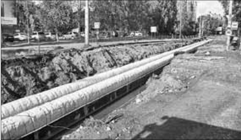
■ За лето силами Архангельских теплосетей ПАО «ТГК-2» было отремонтировано около семи километров сетей. ФОТО: СЕРГЕЙ СЮРИН
